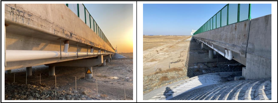
图 7.3-2 桥面径流引水管道
