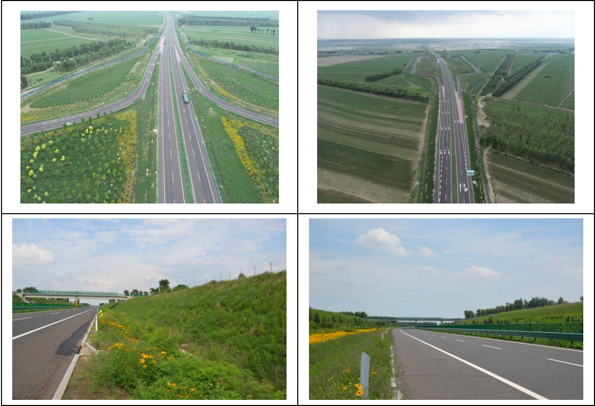
图 5.4-1 边坡防护现状
