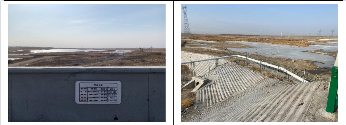
图 7.1-1 本工程沿线河流现状见图
