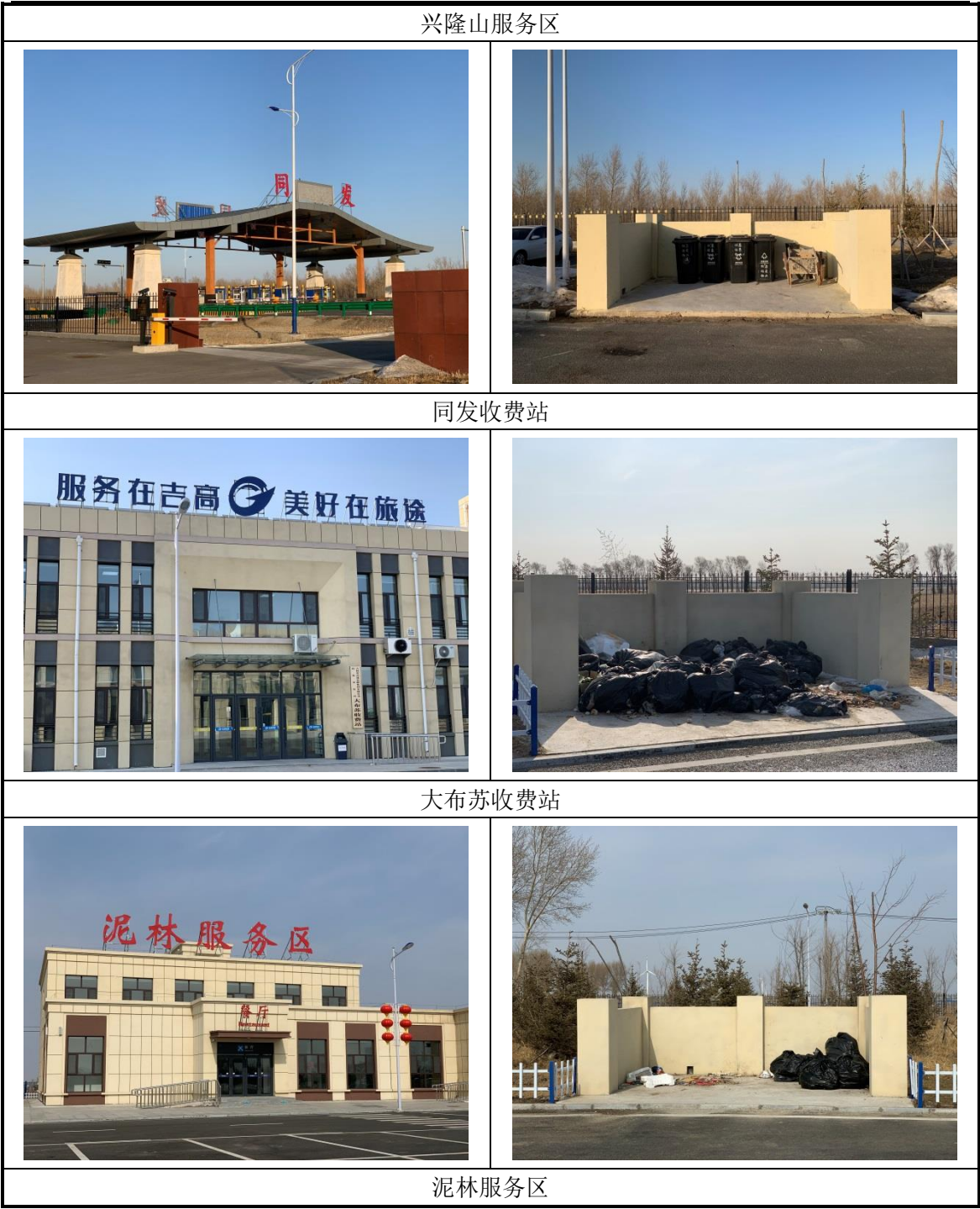
图 8.2-1 沿线服务设施固体废物收集措施
