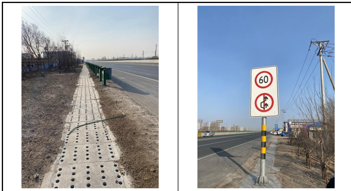
图 7.4-2 限速标志及渗水池
