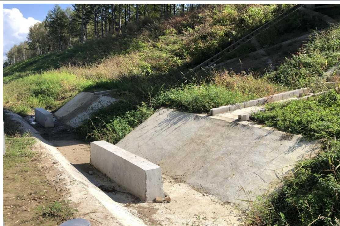
龙蒲 6 标 K123+300 主线路基挖方边坡坡面实施叠拱防护，表土回覆及植灌草绿化植物措施，坡面设置急流槽和消力坎，排水顺接至路基边沟。
