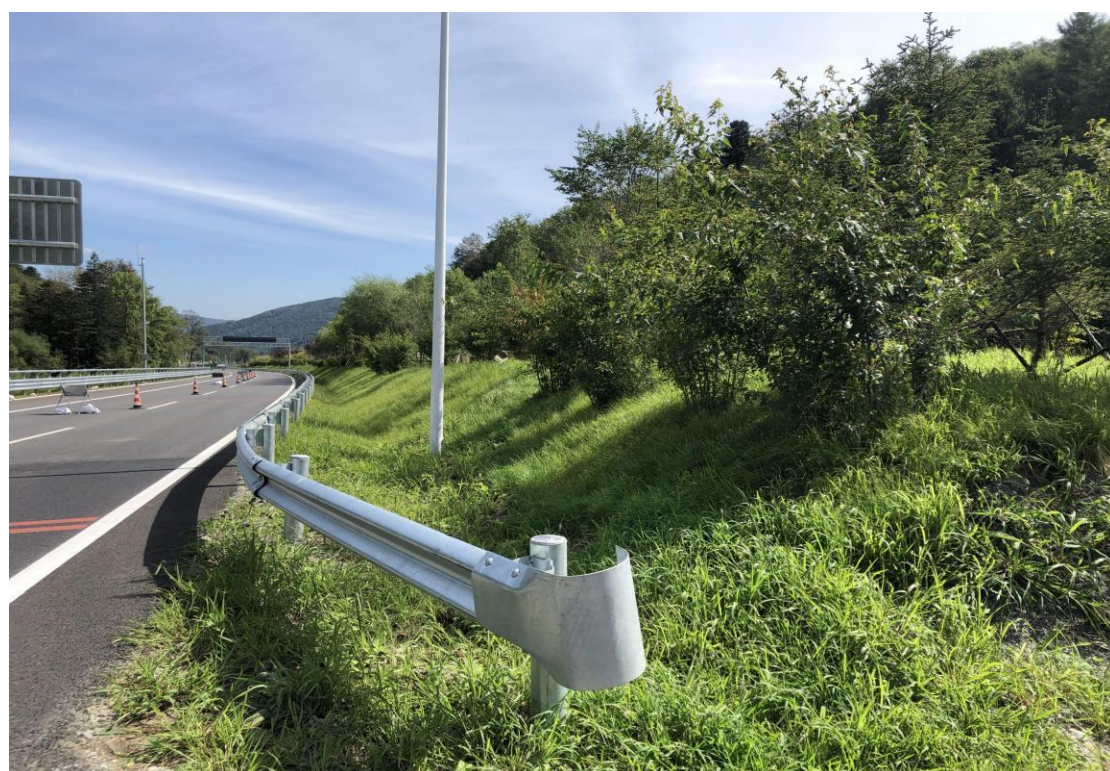
龙蒲 3 标 K79+800 甄峰岭 1 号隧道进口分离式路基，利用弃渣进行微地形改造，回覆表土后，实施乔木、灌木栽植，植草绿化等职务措施。
