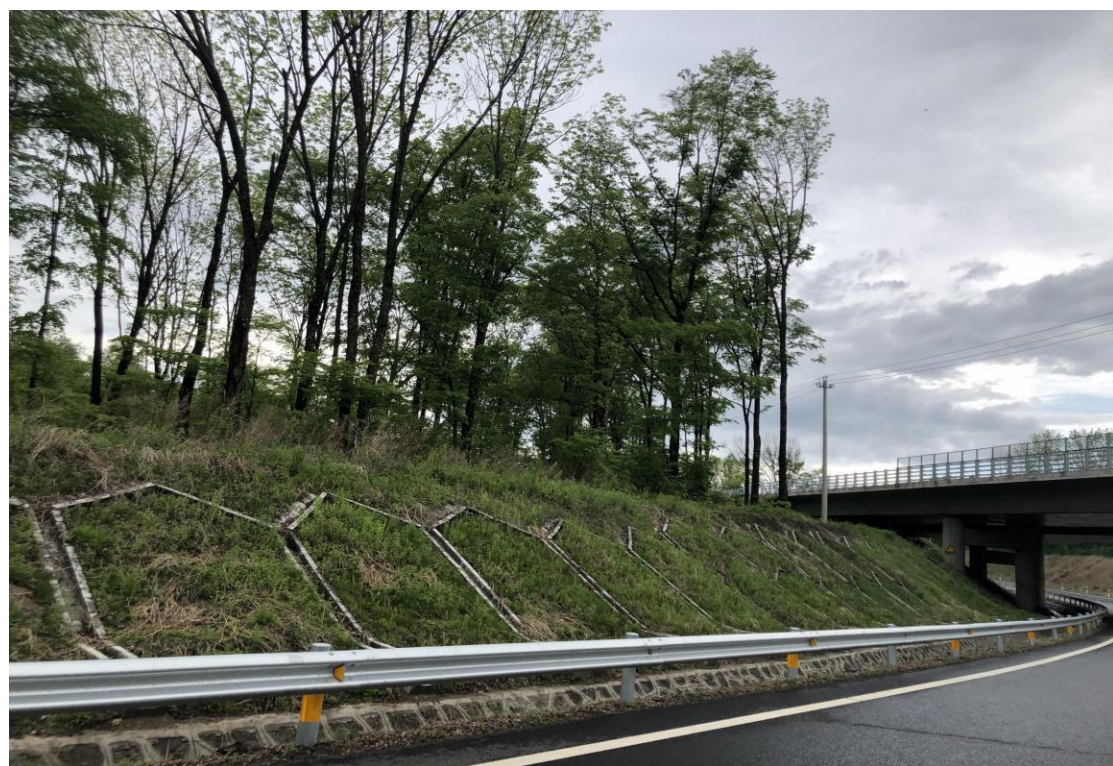
龙蒲 7 标 K128+300 池北互通匝道路基挖方边坡，坡面实施叠拱防护，坡脚设置浆砌边坡，坡面实施灌草绿化。
