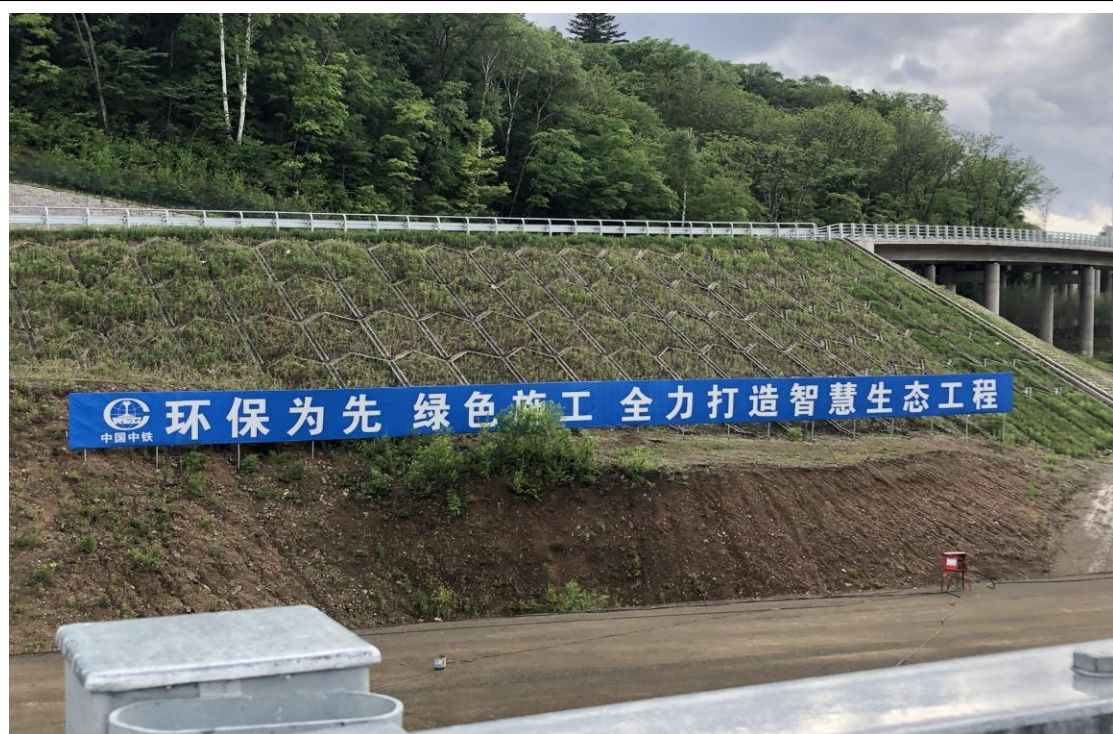
龙蒲 8 标 K168+200 四湖互通匝道路基填方边坡，填方边坡坡面设置叠拱防护，回覆表土后，进行灌草绿化植物措施。
