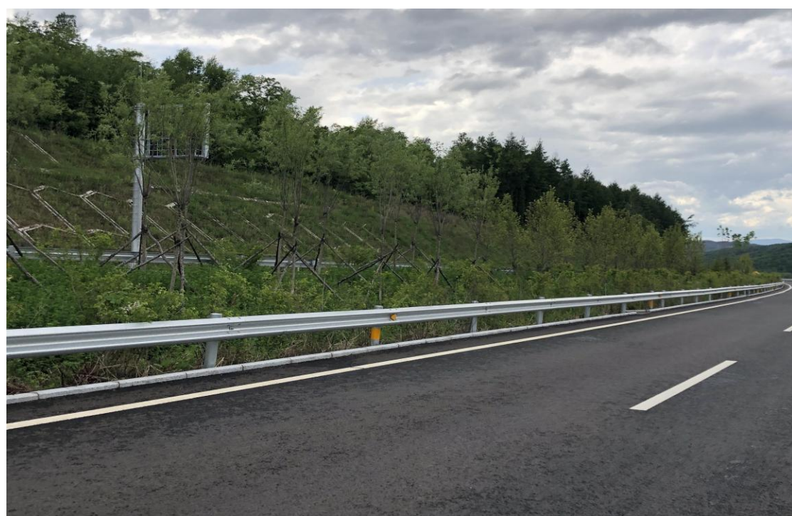
龙蒲 8 标 K137+200 主线路基挖方边坡，挖方边坡坡面实施叠拱防护，坡脚设置边沟，坡面实施灌草绿化，中央分隔带实施灌木栽植、植草绿化等植物措施。
