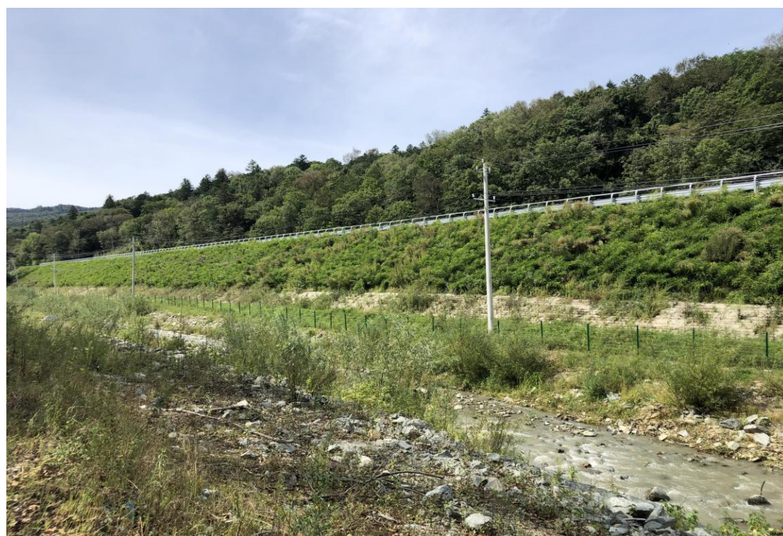
龙蒲 3 标 K78+700 主线路基填方边坡，坡面布设叠拱防护，回覆表土后实施植灌草绿化植物措施。坡脚设置燕尾槽护坡。
