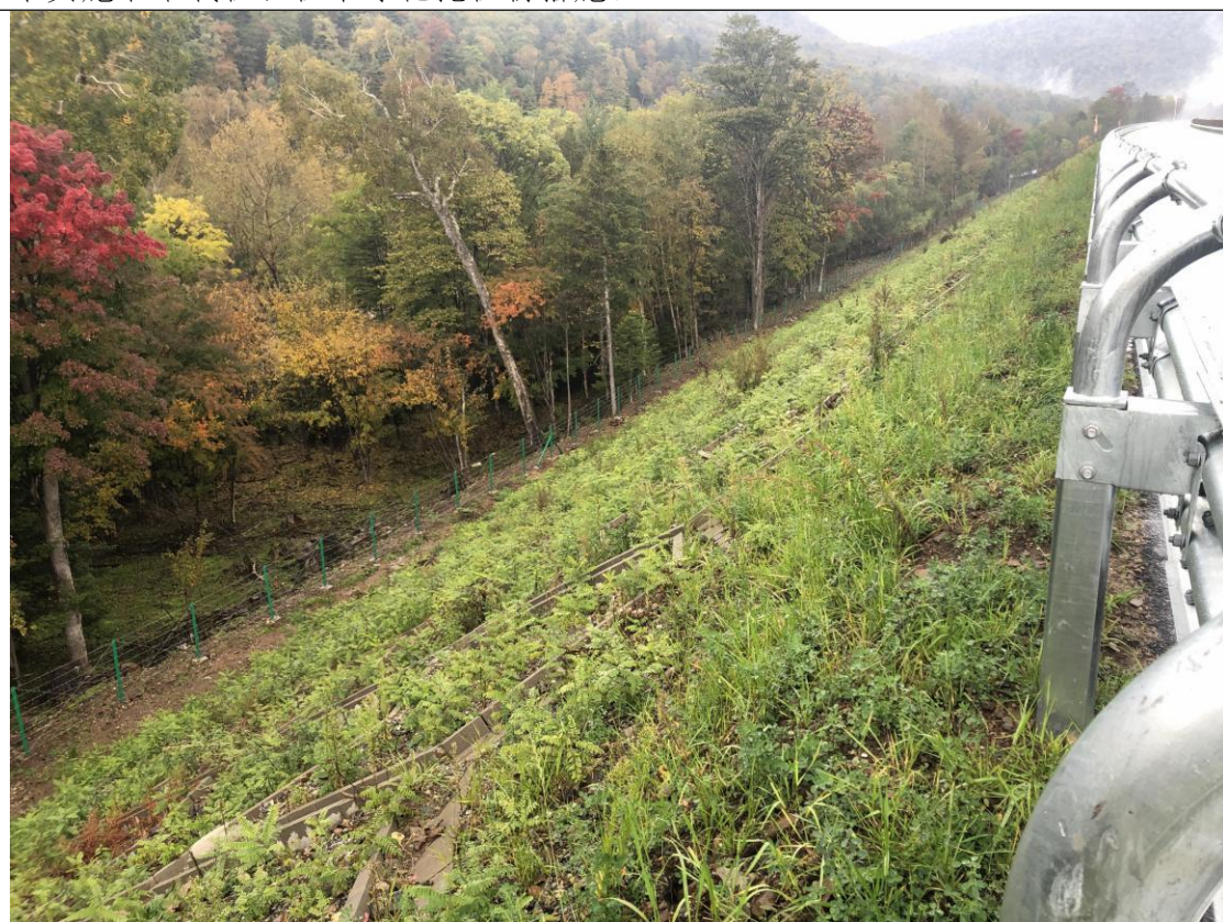
龙蒲 5 标 K97+400 主线路基填方段落，填方边坡坡面设置叠拱防护，回覆表土后，进行灌草绿化植物措施。
