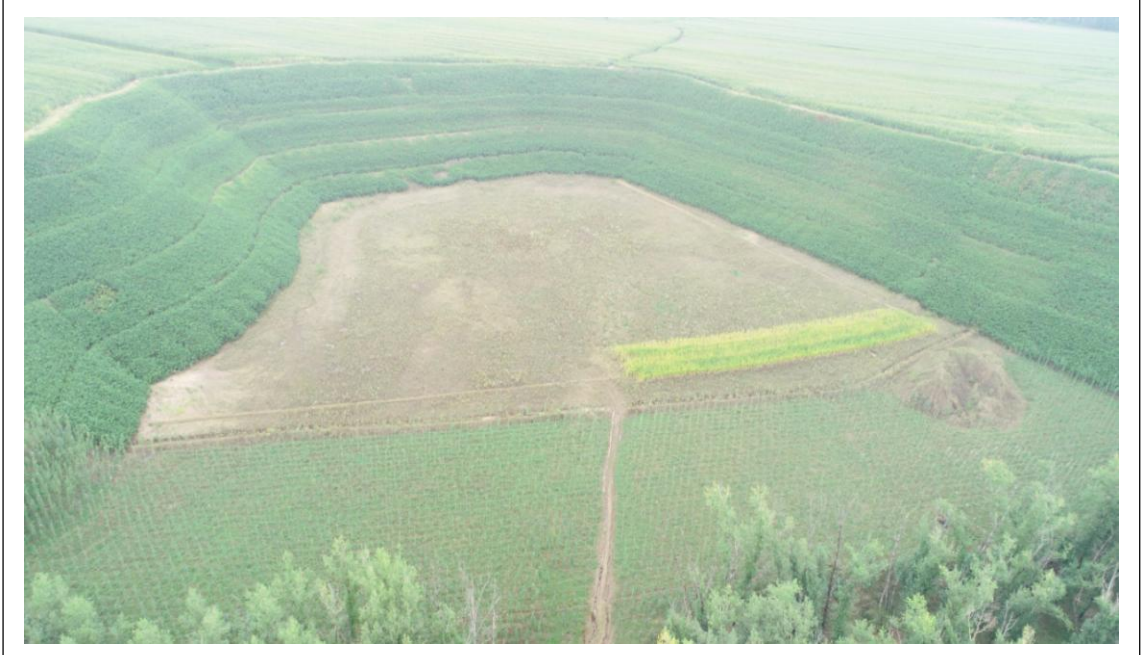
图 10 榆松 5 标 K98+480 陶赖昭取土场，取土场取土结束后，开挖边坡实施叠拱防护，植灌草绿化，开挖平台进行乔灌木栽植，植草绿化，及时复耕复垦。
