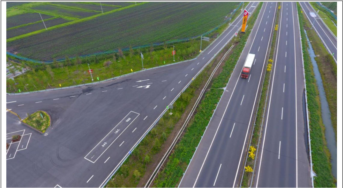
图 7 榆松 4 标 K72+700 永利服务区,服务区外侧边坡实施叠拱防护,灌草绿化,坡脚设置排水沟,场区匝道间景观绿化区实施乔灌木栽植和植草。中分带实施灌木栽植和植草绿化。
