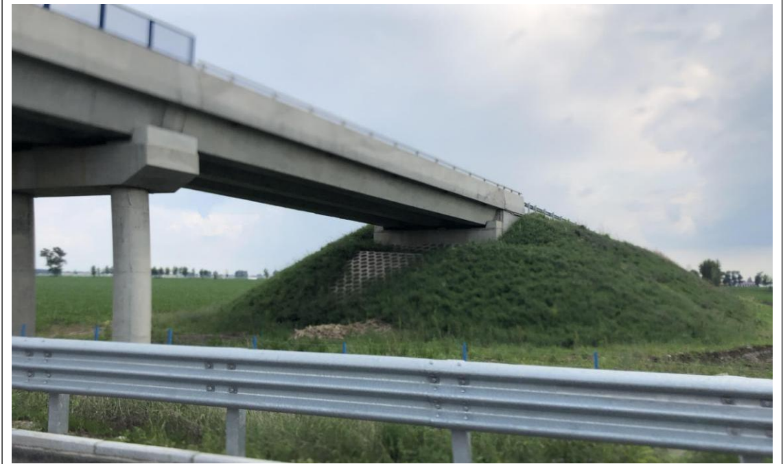
图 8 榆松 4 标 K85+910 跨线天桥,桥梁锥坡和引道边坡均实施叠拱防护和灌草绿化,坡脚设置排水沟。
