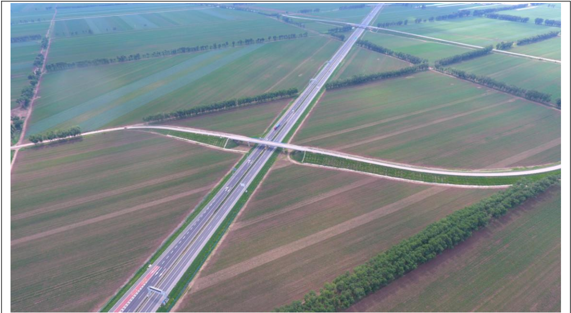
图 9 榆松 5 标 K97+600 主线路基填方段落及跨线天桥，主线及天桥路基边坡实施叠拱防护，表土回覆、植灌草绿化，坡脚实施浆砌排水沟和土质排水沟。
