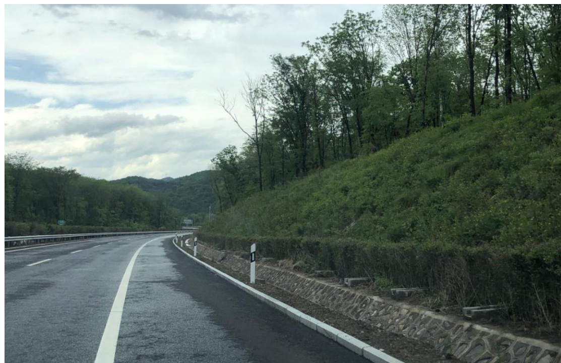
龙蒲 7 标 K130+000 主线路基挖方边坡，坡面实施叠拱护坡，拱内栽植紫穗槐，碎落台栽植灌木紫丁香，坡脚设置浆砌排水沟，路面设置拦水带。
