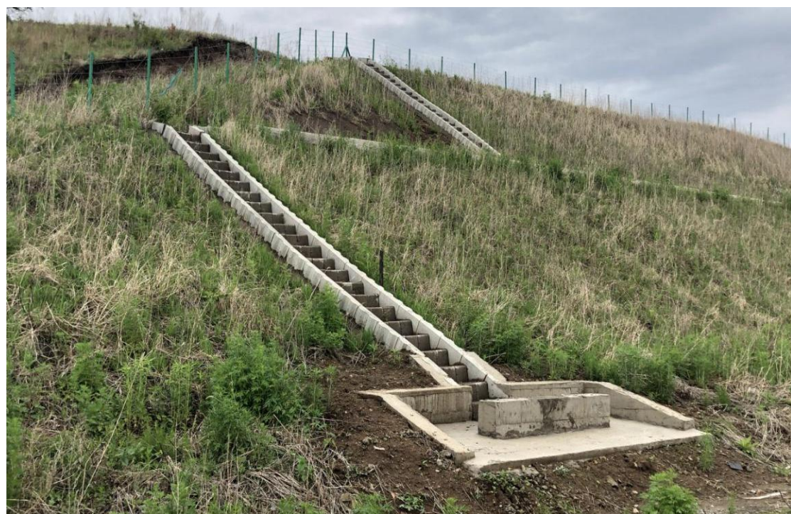
龙蒲 8 标 K143+300 主线路基挖方边坡坡面实施叠拱防护，表土回覆及植灌草绿化植物措施，平台布设浆砌截水沟，坡面设置急流槽和消力坎，顺接至主路排水沟。
