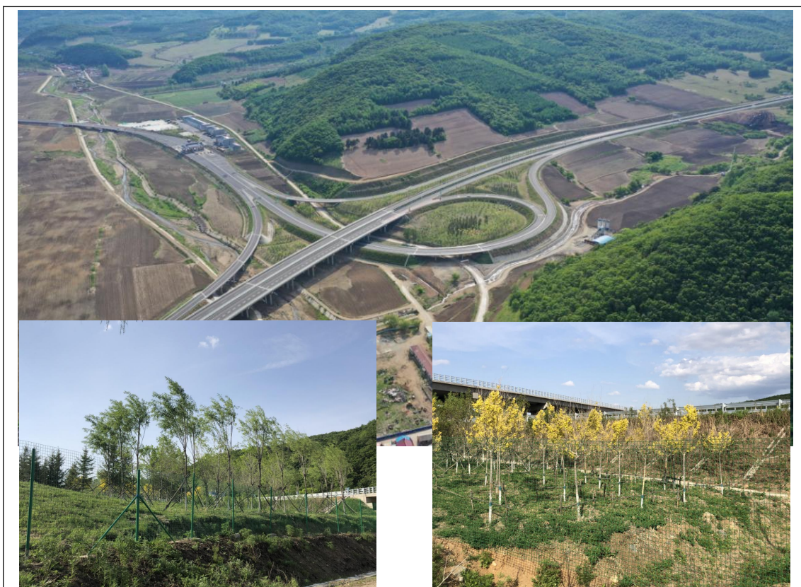
龙蒲 2 标 K55+990 和龙互通，互通立交区实施景观绿化，乔灌木栽植，撒播草籽，路基边坡实施叠拱防护、灌草绿化，坡脚实施浆砌排水沟和土质排水沟。
