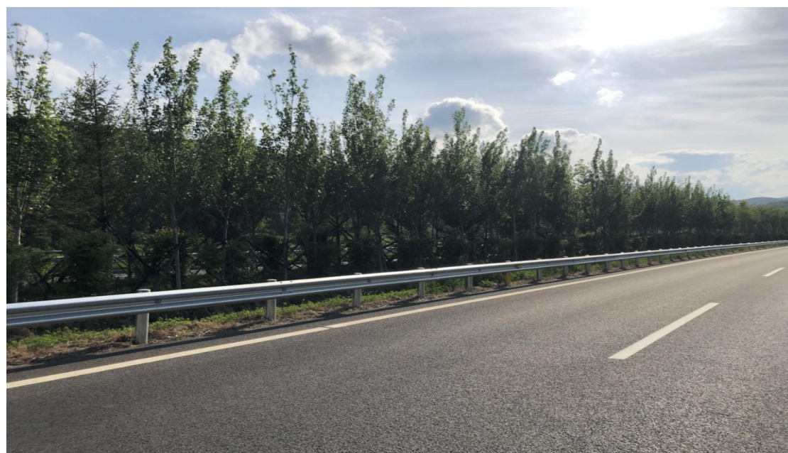
龙蒲 2 标 K63+680 鸡南隧道出口分离式路基，分离式路基实施全面整地，乔灌木栽植，撒播植草等植物措施。
