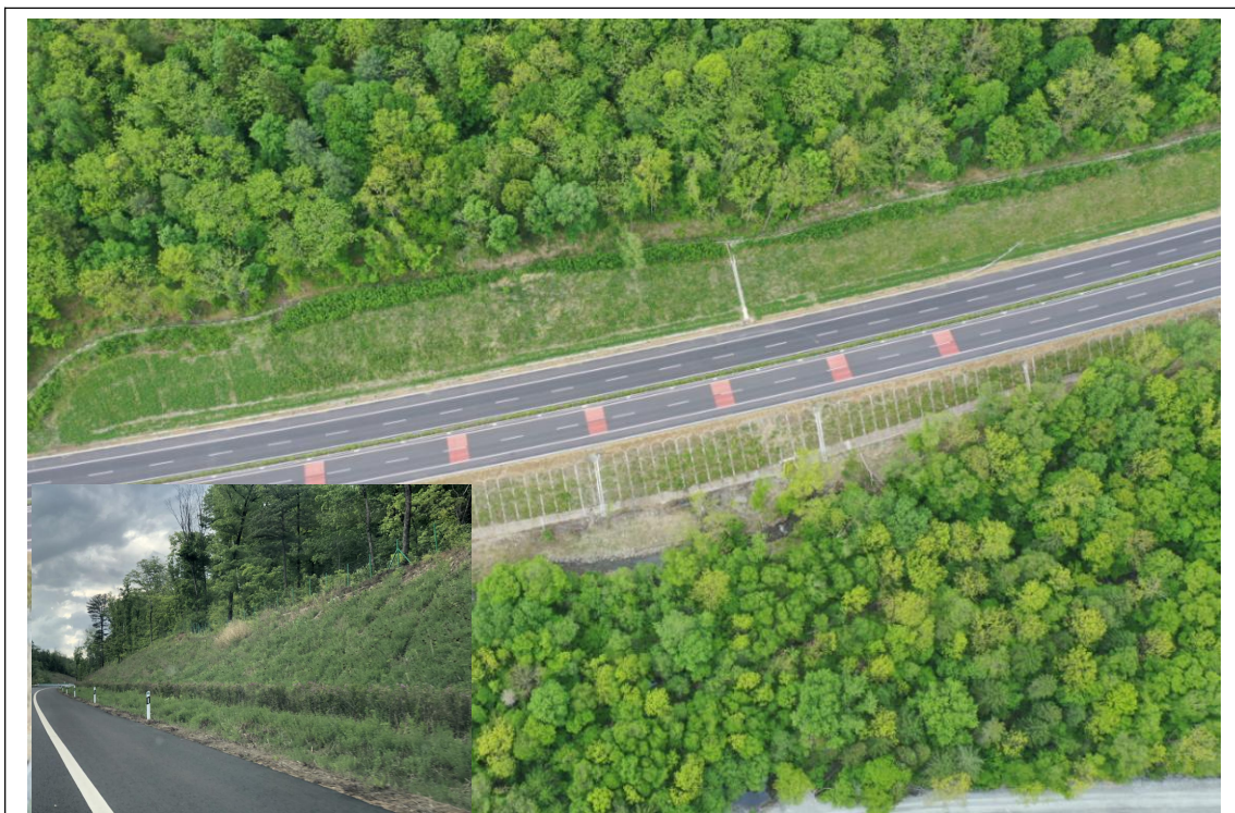
龙蒲 3 标 K77+600 主线路基挖填方边坡，挖方边坡实施坡顶截水沟，坡面急流槽，坡脚排水沟，坡面实施灌草绿化，填方边坡实施叠拱防护，坡面急流槽，消力坎，叠拱防护，坡脚排水沟，坡面实施灌草绿化。
