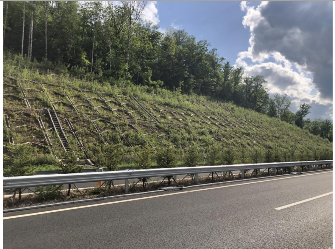
龙蒲 9 标 K157+200 主线路基挖方边坡，挖方边坡坡面设置叠拱防护，拱内实施灌草绿化，坡面设置急流槽，消力坎，坡脚设置排水沟。中央分隔带栽植灌木云杉，撒播草籽等植物措施。
