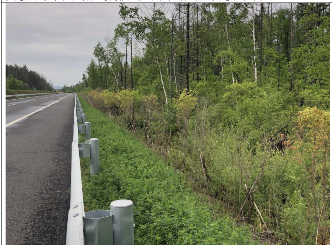
龙蒲 7 标松长联络线 LK10+000 主线路基填方边坡，填方边坡进行紫穗槐灌木栽植，路侧栽植灌木，生态排水沟实施撒播草籽等植物措施。
