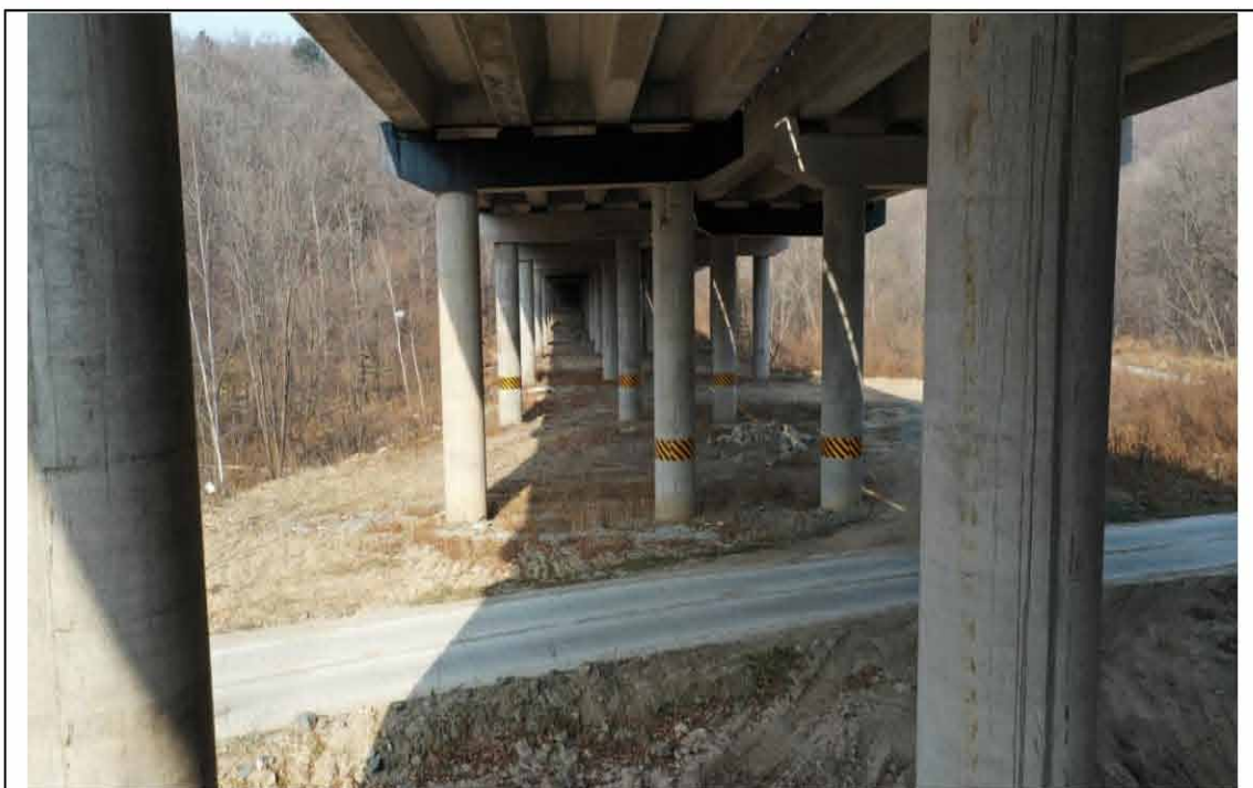
龙蒲 9 标 K164+140 四湖 3 号大桥，桥梁施工结束后，对桥下迹地进行了全面整地，回覆表土，撒播草籽等措施。
