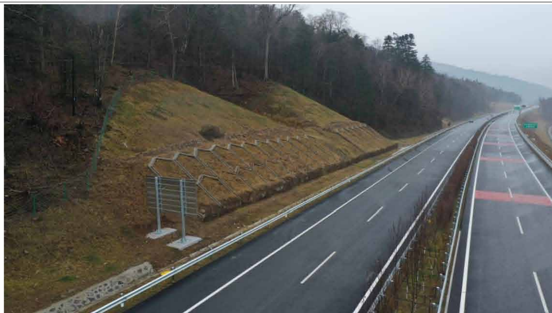
龙蒲 5 标 K96+000 主线路基挖方边坡，坡面实施叠拱防护，表土回覆及植灌草绿化植物措施，坡脚场地平整后设置浆砌和生态排水沟，中央分隔带实施场地平整，表土回覆和植灌草绿化等措施。
