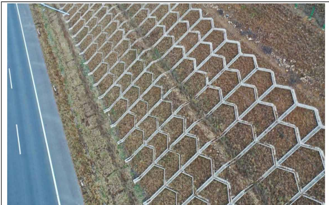
龙蒲 6 标 K102+800 主线路基挖方边坡，实施叠拱防护、表土回覆及植灌草绿化等措施，坡脚设置生态排水沟。
