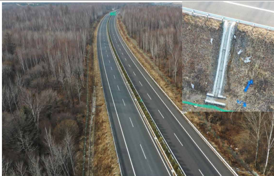
龙蒲 7 标 K124+000 主线路基填方边坡，坡面进行修整，植草绿化，坡脚设置排水沟。
