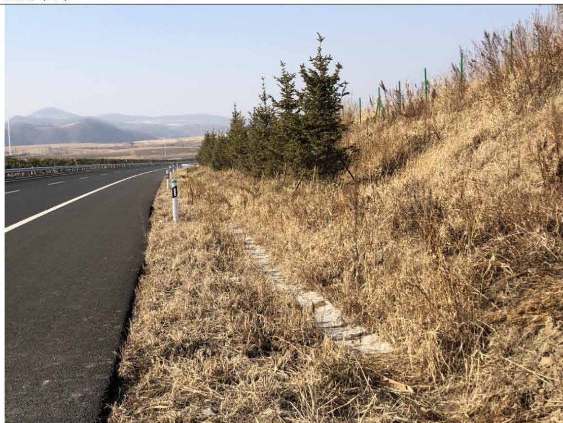
龙蒲 8 标 K143+200 主线路基挖方边坡，实施表土回覆及植灌草绿化等措施，坡脚设置排水沟，碎落台进行了乔木栽植。
