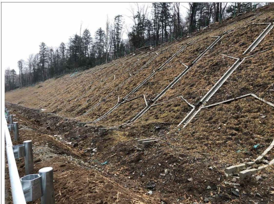
龙蒲 4 标 K89+500 主线路基挖方边坡，实施叠拱防护、表土回覆及植灌草绿化等措施，坡脚设置生态排水沟。
