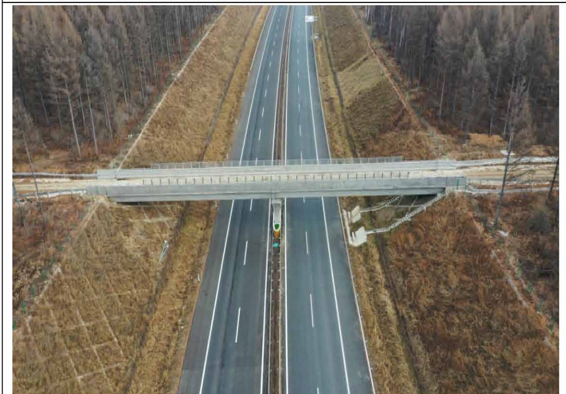
龙蒲 6 标 K123+300 主线路基挖方边坡坡面实施菱形防护，表土回覆及植灌草绿化植物措施，坡脚场地平整后设置生态排水沟，跨线天桥引道两侧设置排水沟，并设置急流槽和消力坎，顺接至主路排水沟。
