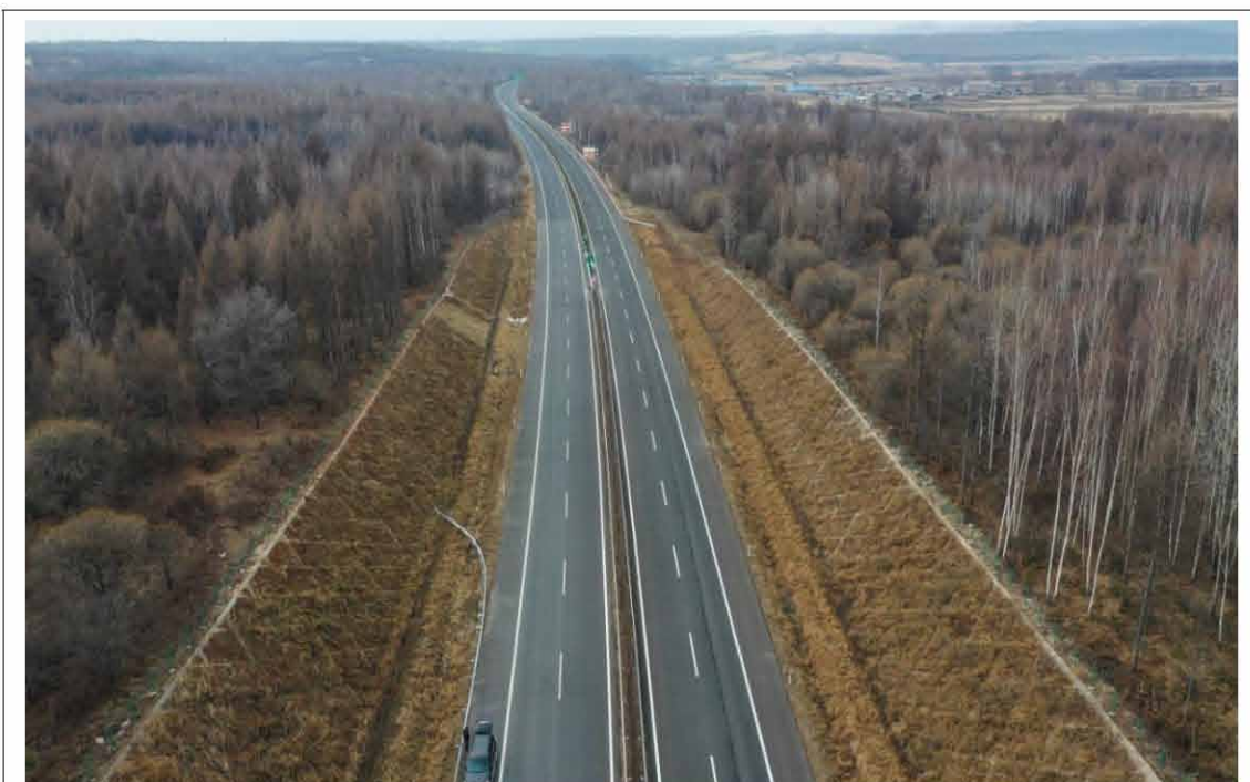
龙蒲 7 标 K123+400 主线路基挖方边坡坡面实施菱形叠拱防护，表土回覆及植灌草绿化植物措施，坡脚场地平整后设置生态排水沟，坡顶布设截水沟，中央分隔带实施场地平整，表土回覆和植灌草绿化等措施
