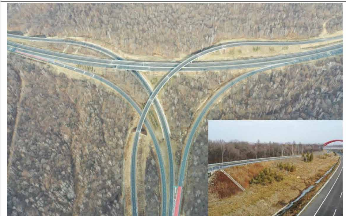
龙蒲 7 标 K128+300 池北互通，施工时减少了对原生植被的扰动，对主线和匝道路基边坡布设叠拱防护，回覆表土和植草绿，坡脚设置截排水沟，绿化区域进行了乔灌草绿化栽植等措施。
