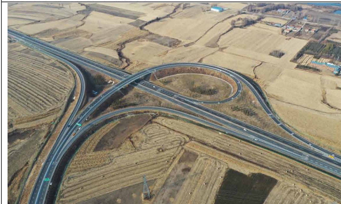
龙蒲 6 标 K120+565 松江互通，主线路基及匝道挖填方边坡实施叠拱防护、表土回覆及植灌草绿化等措施；互通绿化区域实施场地平整，表土回覆及栽植乔灌木绿化等措施，中央分隔带实施场地平整，表土回覆及植草植灌绿化等措施；边坡坡面实施急流槽，坡脚实施边沟排水沟等排水防护措施。
