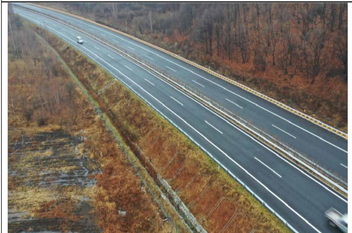
龙蒲 2 标 K64+300 主线路基填方边坡, 坡面实施衬砌拱护坡防护, 表土回覆及植灌草绿化等措施, 坡脚设置浆砌石排水沟与坡面急流槽相接。占地界护栏内外侧均实施撒播植草绿化等植物措施。
