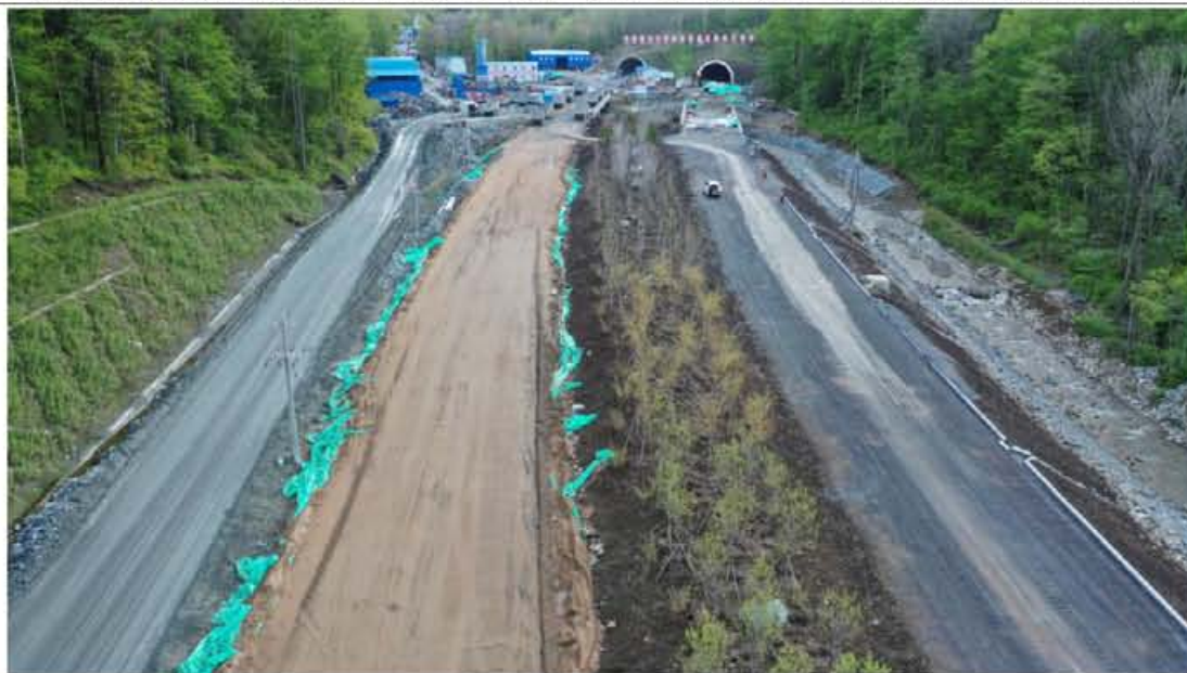
龙蒲3标 K79+600 主线路基分离式路基实施场地平整，表土回覆，乔灌木栽植及 植草绿化等措施。
