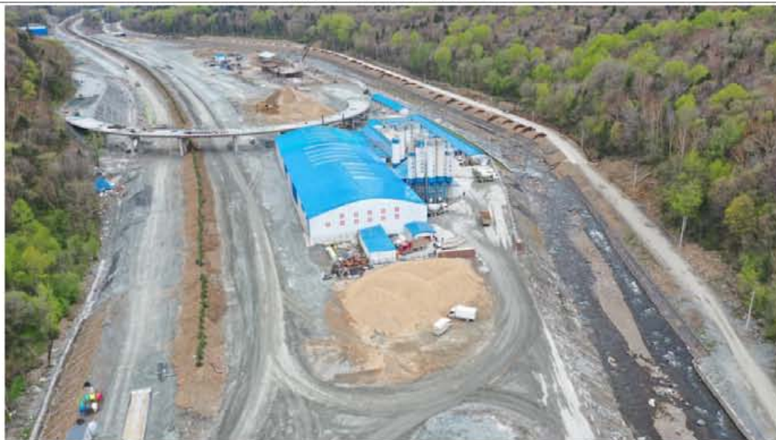
龙蒲 4 标古洞河服务区填方边坡设置叠拱防护及边沟排水沟，改河河岸设置铅丝石笼及燕尾槽护坡等形式的护岸措施。
