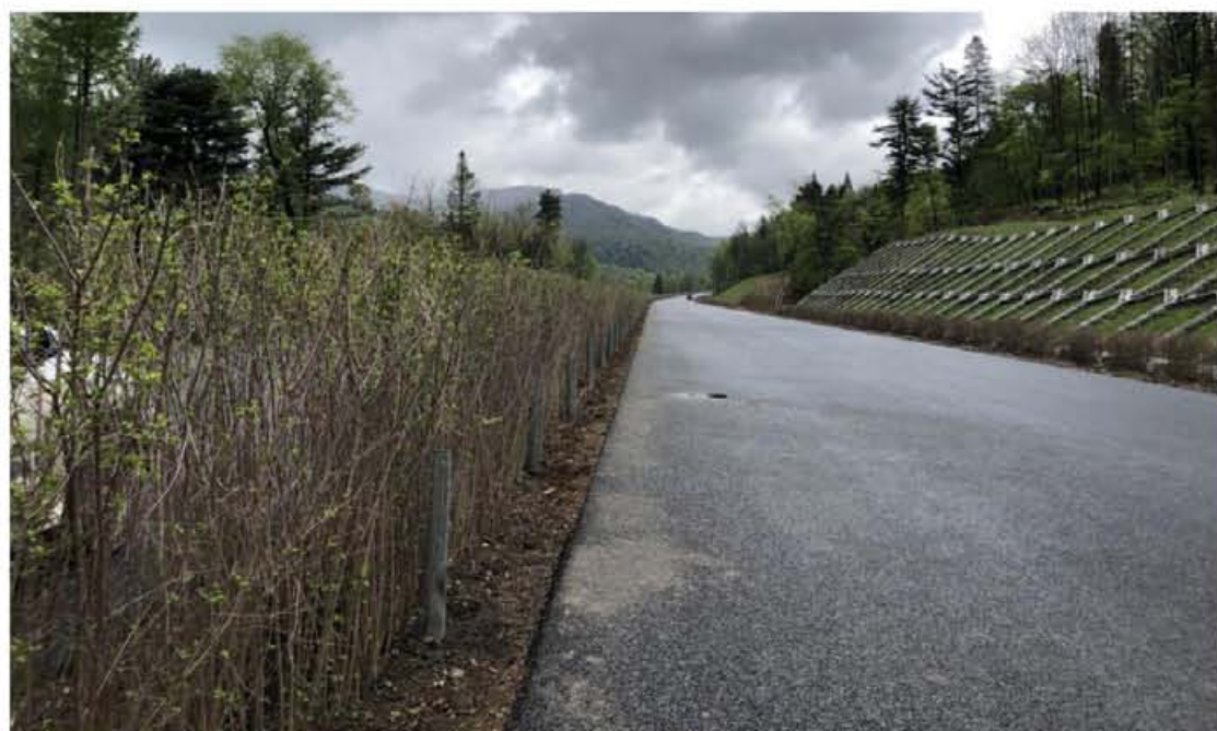
龙蒲 5 标 K100+800 主线路基挖方边坡实施叠拱防护，表土回覆及植草绿化；路侧平台实施乔灌木栽植；坡脚实施边沟排水沟；中央分隔带实施场地平整，灌木栽植和植草绿化等措施。
