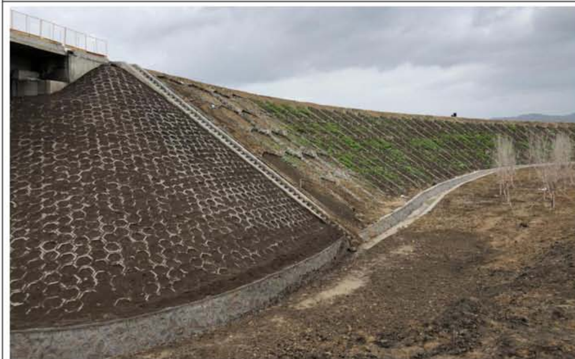
龙蒲 6 标 K120+527 松江互通桥台锥坡实施六棱砖护坡并回覆表土；填方边坡实施叠拱护坡及植草绿化；坡脚实施边沟排水沟；互通绿化区实施场地平整，表土回覆，乔灌木栽植等措施。
