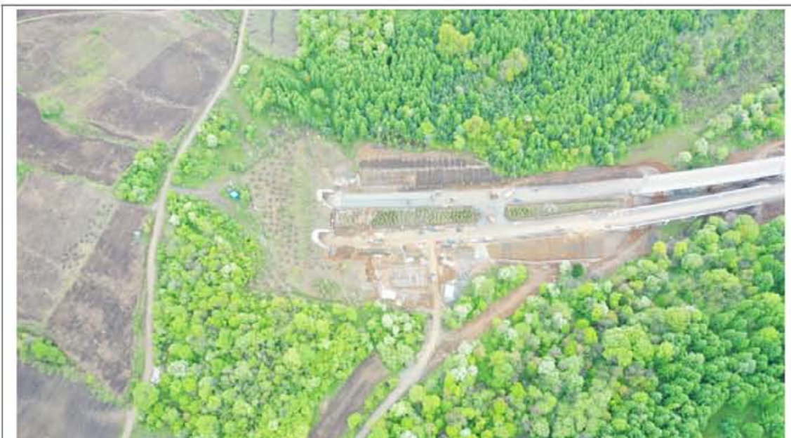
龙蒲 8 标 K135+250 两江隧道进口洞顶坡面实施乔灌木栽植和植草绿化，坡顶设置截水沟；路基两侧挖方边坡实施叠拱防护和植草绿化；分离式路基实施场地平整，表土回覆，乔灌木栽植和植草绿化等措施。
