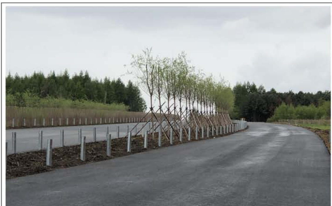
龙蒲 6 标 K113+230 松江停车区中央分隔带实施场地平整，乔灌木栽植和植草绿化等措施。
