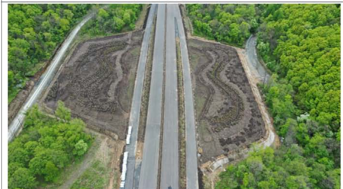
龙蒲2标 K71+800 和龙停车区填方边坡实施叠拱防护措施，场区内实施乔灌木栽植及植草绿化措施，匝道实施边沟排水沟措施。
