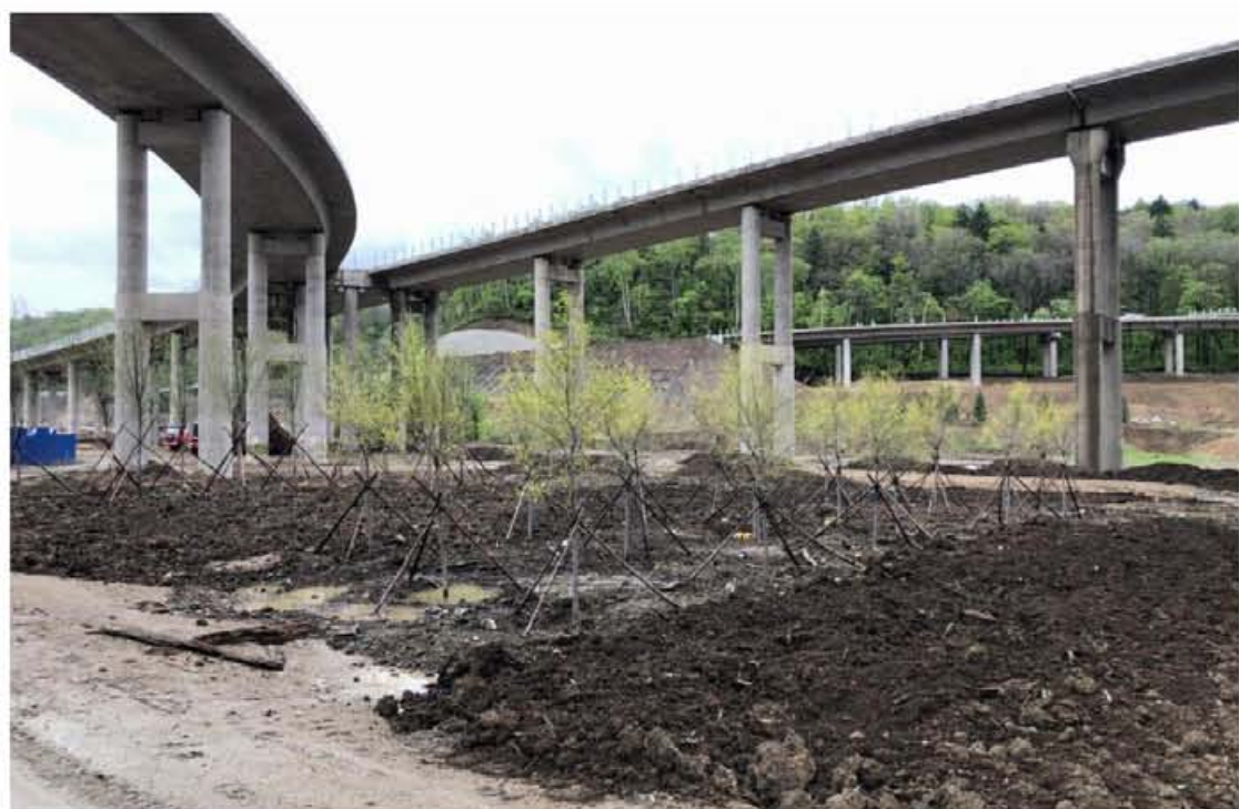
龙蒲9标四湖互通部分挖填方边坡实施叠拱防护，表土回覆和植草绿化；部分互通绿化区实施场地平整，表土回覆和乔灌木栽植等措施。
