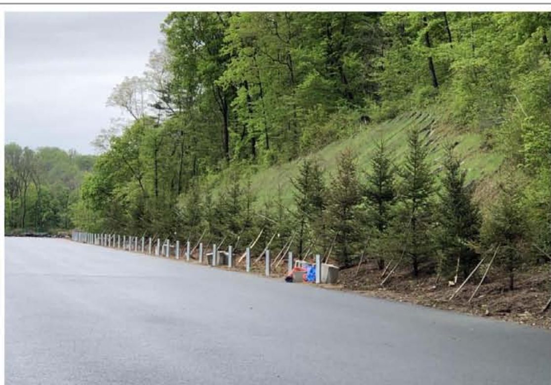
龙蒲9标 K162+500 主线路基挖方边坡实施叠拱防护，表土回覆和植草绿化，路侧实施乔灌木栽植；坡脚实施边沟排水沟等措施。
