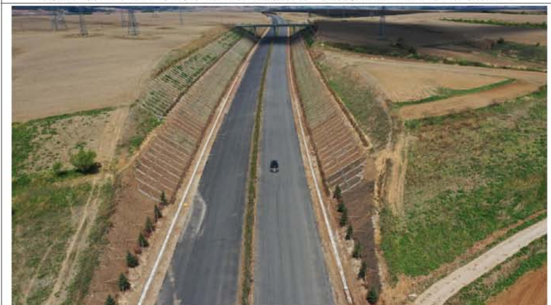
龙蒲 1 标 K42+900 主线路基挖方边坡实施叠拱防护及植草绿化等措施；中央分隔带实施场地平整，植草植灌绿化等措施；路侧实施栽植乔木；坡脚实施边沟排水沟等措施。
