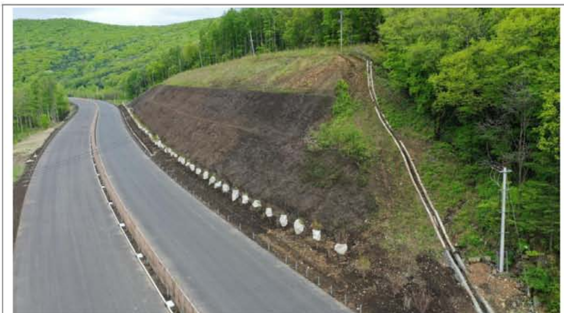
龙蒲2标 K66+900 主线路基挖方边坡实施叠拱防护及植草绿化等措施；中央分隔带实施场地平整，植草植灌绿化等措施；路侧实施栽植乔木；坡顶坡脚实施截水沟、排水沟等措施。
