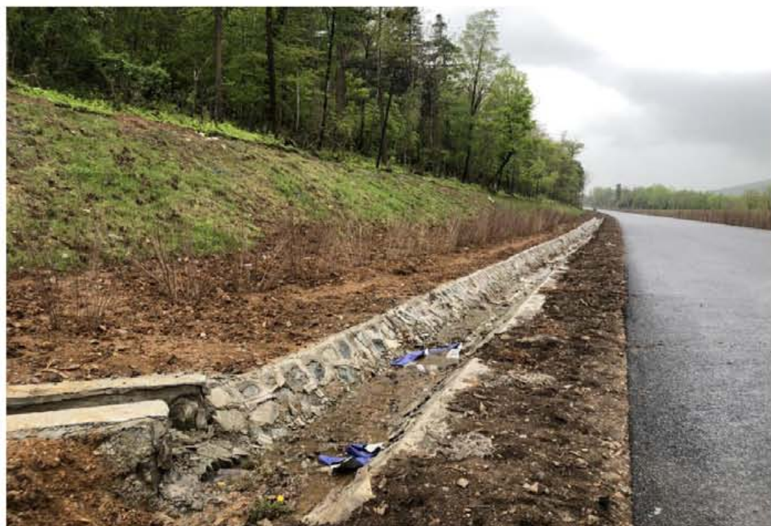
龙蒲 5 标 K100+100 主线路基挖方边坡实施边坡修整，表土回覆及植草绿化；路侧平台实施乔灌木栽植；坡脚实施边沟排水沟等措施。
