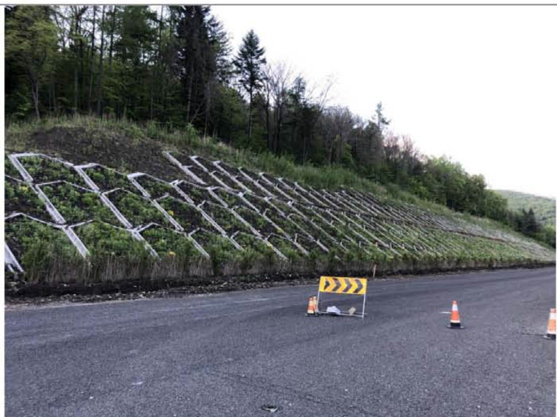
龙蒲 3 标 K76+700 主线路基挖方边坡实施叠拱防护，表土回覆和植草绿化，路侧实施乔灌木栽植；坡脚实施边沟排水沟等措施。
