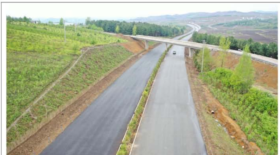
龙蒲 8 标 K139+200 主线路基挖方边坡实施叠拱防护，表土回覆及植草绿化；填方边坡实施坡面平整，表土回覆及植草绿化；坡脚实施边沟排水沟；中央分隔带实施场地平整，灌木栽植和植草绿化等措施。
