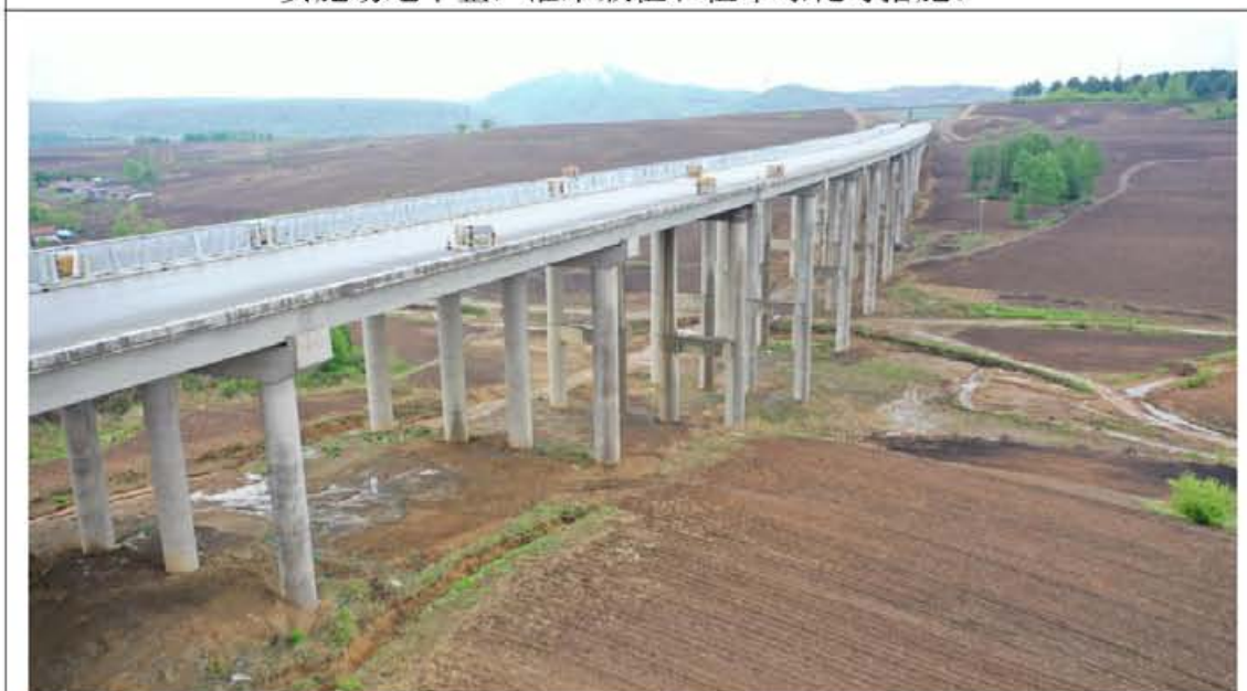
龙蒲 8 标 K142+082 两江 2 号大桥施工结束后实施桥下迹地平整，植草绿化。
