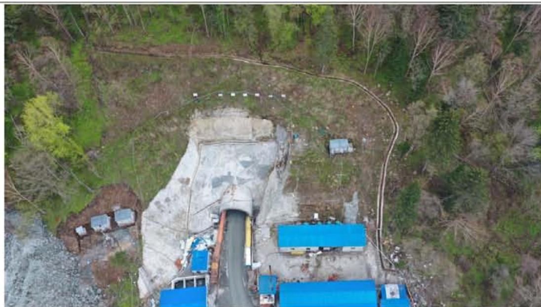
龙蒲 3 标甄峰岭 1 号隧道斜井隧道出口洞顶坡面实施乔灌木栽植，植草绿化；洞口坡面实施硬化防护，坡顶实施截水沟等措施。
