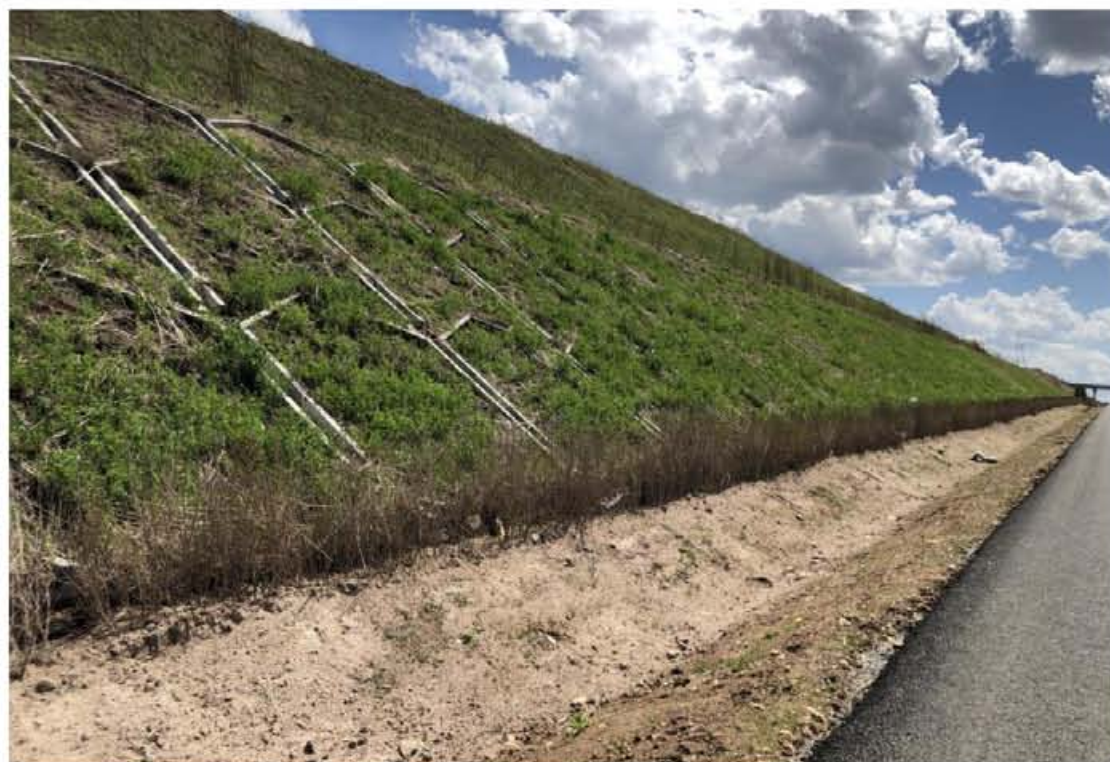
龙蒲 1 标 K40+770 主线路基挖方边坡实施叠拱防护，表土回覆和植草绿化，路侧实施乔灌木栽植；坡脚实施边沟排水沟等措施。
