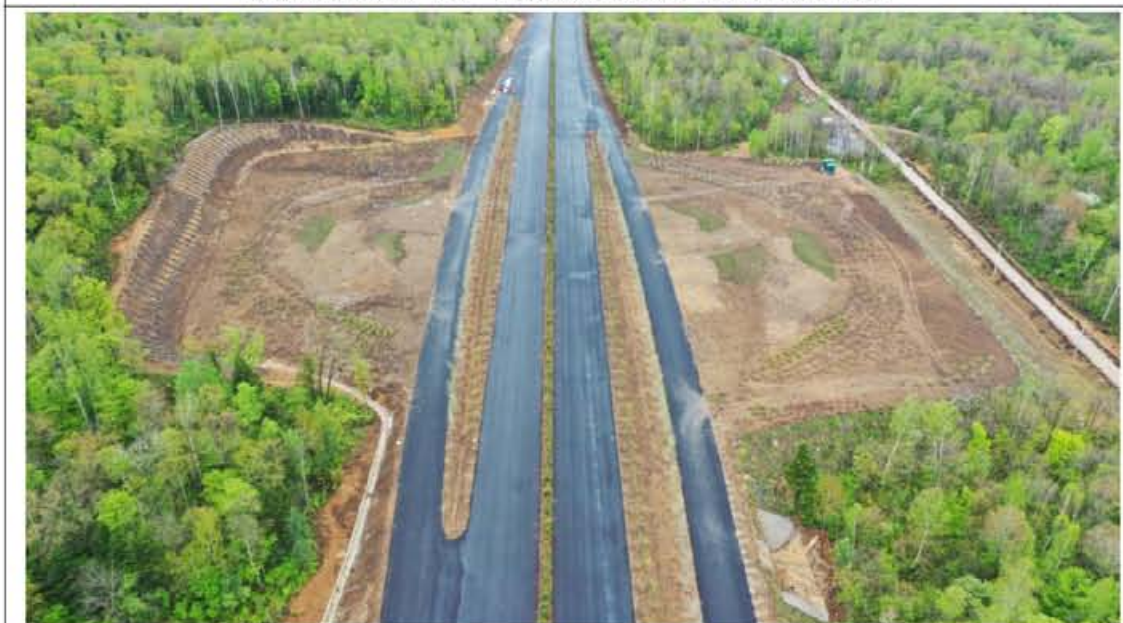
龙蒲9标四湖停车区挖填方边坡实施叠拱防护措施，场区内实施乔灌木栽植及植草绿化措施，匝道实施边沟排水沟。
