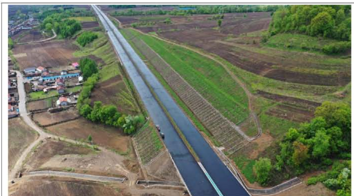
龙蒲 6 标 K106+000 主线路基挖方边坡实施叠拱防护，表土回覆，植草绿化措施；填方边坡实施叠拱防护，表土回覆，植草绿化措施，坡脚实施边沟排水沟。
