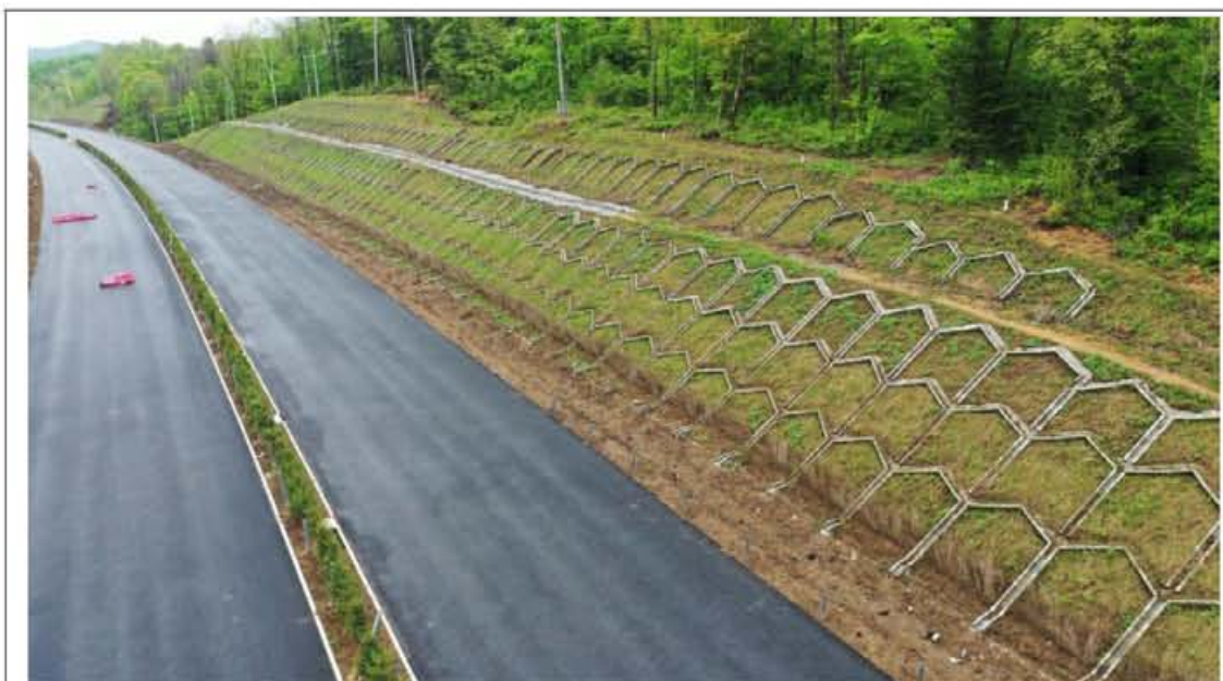
龙蒲9标 K155+800 主线路基挖方边坡实施叠拱防护，表土回覆及植草绿化；路侧平台实施乔灌木栽植；坡面平台实施截水沟，坡脚实施边沟排水沟；中央分隔带实施场地平整，灌木栽植和植草绿化等措施。
