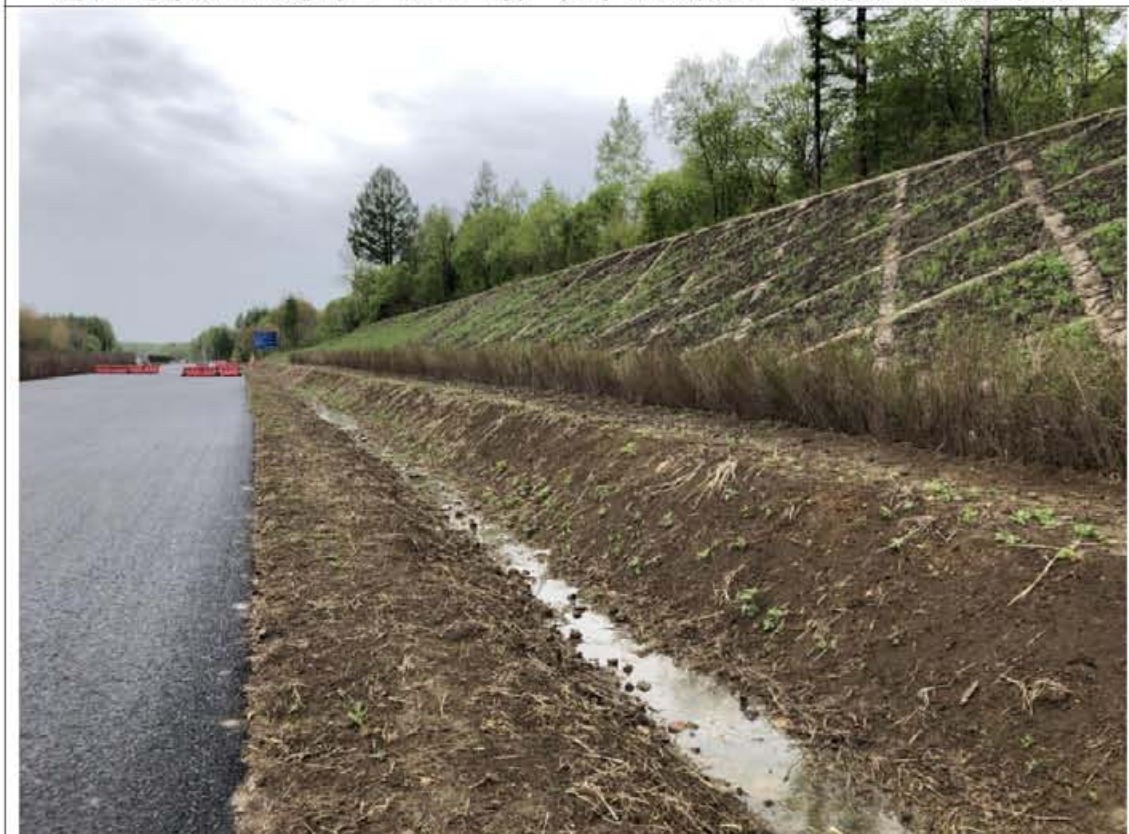
龙蒲 6 标 K123+400 主线路基挖方路基实施叠拱防护，表土回覆和植草绿化；坡脚实施排水沟等措施。
