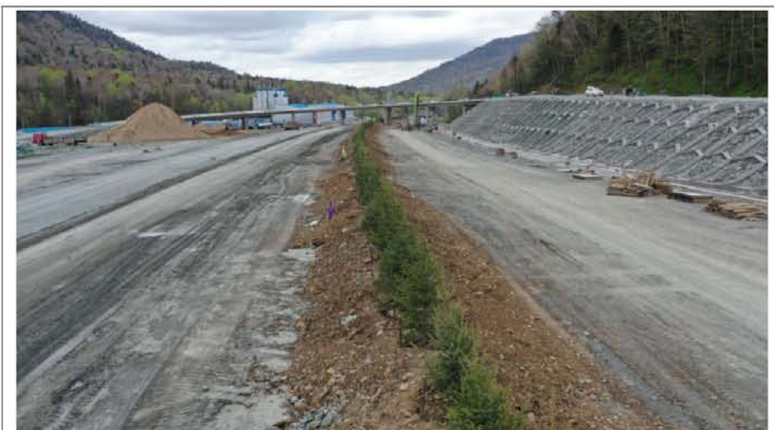
龙蒲 4 标 K88+200 主线路基挖方边坡实施叠拱防护，坡脚实施边沟排水沟；中央分隔带实施场地平整，表土回覆，灌木栽植等措施。
