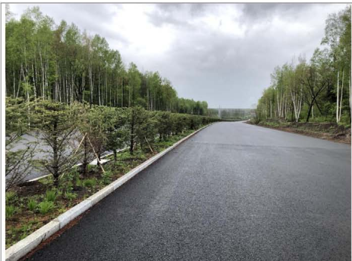
龙蒲 7 标 K124+900 主线路基中央分隔带实施场地平整，乔灌木栽植和植草绿化等措施。
