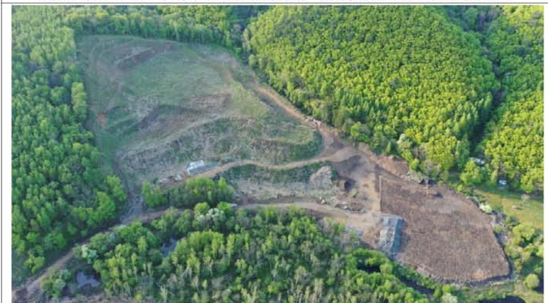
龙蒲 2 标 K72+930 十四公里取土场取土结束后，实施场地平整，表土回覆，乔灌木栽植等水土保持防治措施。
