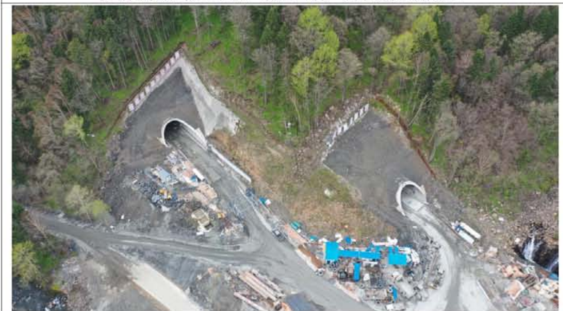
龙蒲 4 标甄峰岭 2 号隧道进口洞顶实施硬化防护，边坡坡顶实施截水沟。
