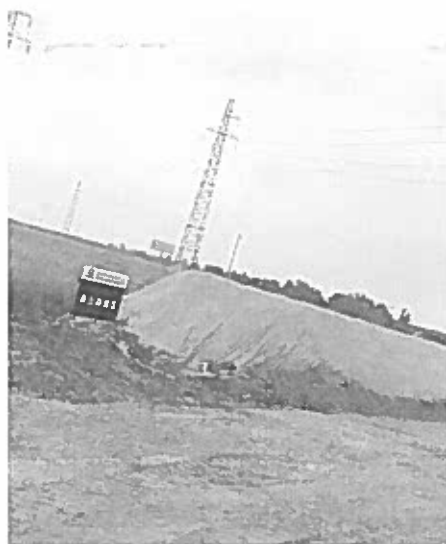
6 工区表土存放
