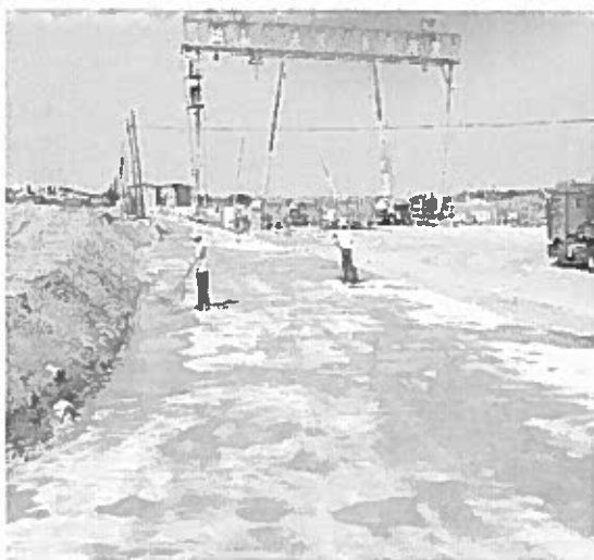
5 工区梁场洒水清扫
